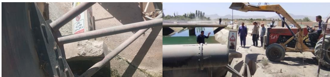
شکل (۲): مسدود نمودن آبگیر با وزنه بتنی
